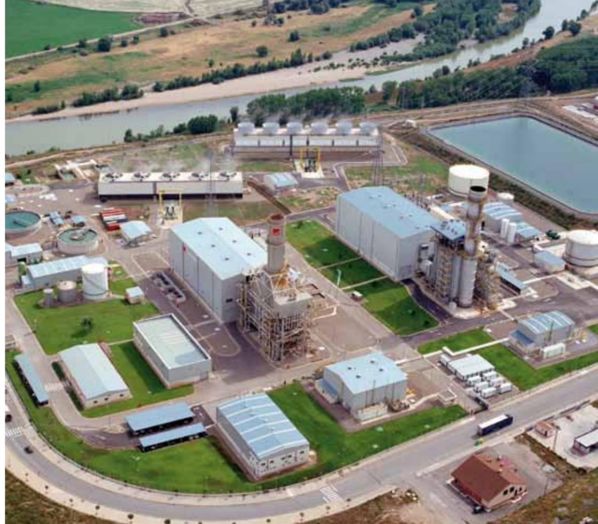
La instalación consta de dos grupos en funcionamiento, el primer grupo (Castejón 1) desde el año 2002 y el segundo (Castejón 3) desde comienzos de 2008. Cada uno de ellos se compone de una turbina de gas y una turbina de vapor dispuestas sobre un único eje, de modo que sólo disponen de un alternador para la generación de energía eléctrica instalado entre ambas turbinas.
