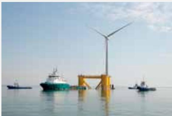
O projeto WindFloat engloba a conceção e construção de um protótipo onde é montada uma turbina eólica de 2 MW. O protótipo foi instalado ao largo da costa portuguesa, perto de Aguçadoura, e ligado à rede elétrica em finais de dezembro de 2011. Trata-se do primeiro projeto de instalação de turbinas eólicas *offshore* em todo o mundo que não implicou a utilização de pesados sistemas de construção e montagem no mar.
